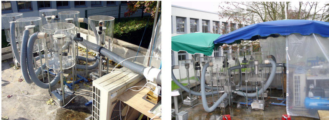
Figure 8 : Vues générales de l'installation en toiture
